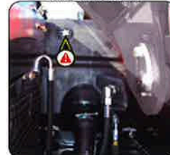
HET NIVEAU VAN DE HYDRAULISCHE OLIE CONTROLEREN
